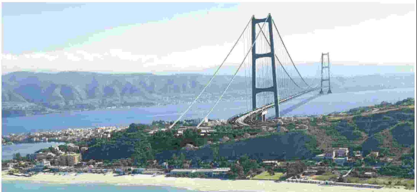
Una elaborazione grafica del progetto del ponte sullo Stretto di Messina, dove si prevede una campata unica di 3.300 metri, come sul modello di Eurolink
