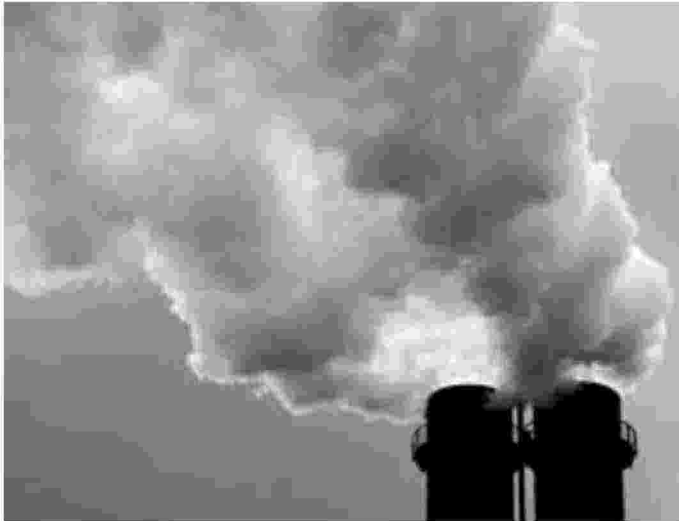
Centrale elettrica di riscaldamento a Berlino foto AP
