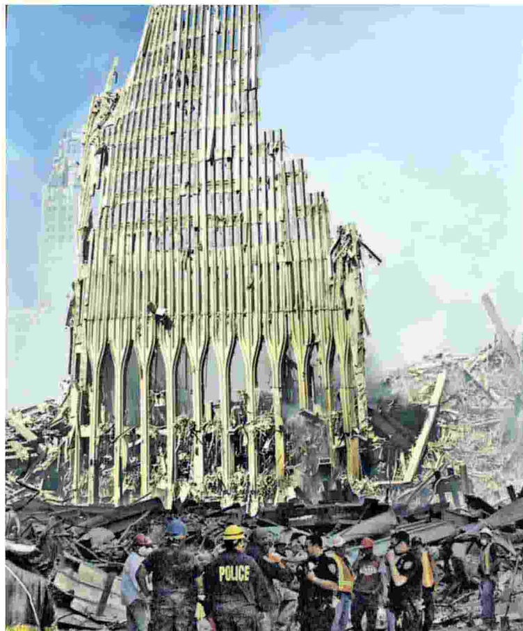
▲ New York I resti delle Torri Gemelle dopo l'11 settembre 2001
